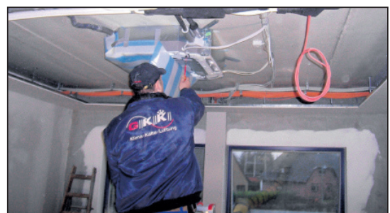
Monteure bei der Installation einer modernen Klima- und Lüftungsanlage.
